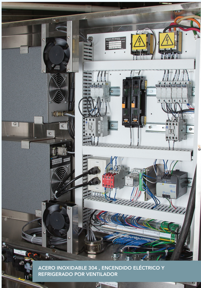
BUENA IDENTIFICACION Y FÁCIL ACCESO MECÁNICO Y COMPONENTES ELÉCTRICOS.
